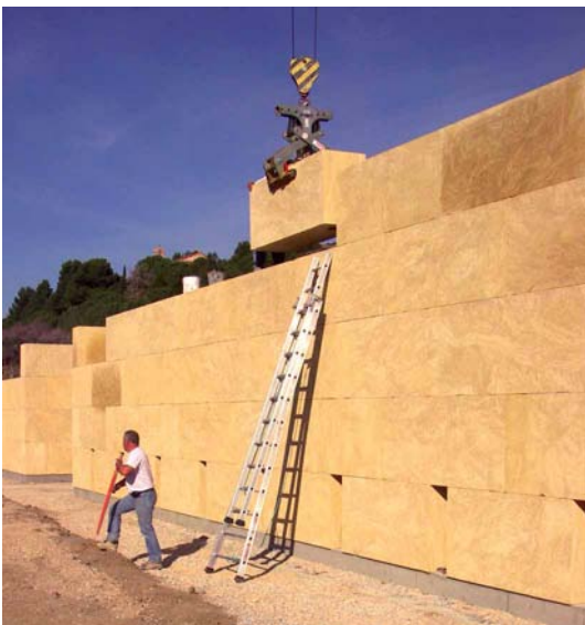
450 blocs de 2,5 t., ont été posés au rythme de 40 t. par jour. Pascal Carrère a carrément acheté la pince qui a permis la mise en œuvre de la pierre. Un chaînage béton anti-sismique a été réalisé. La carrière S.O.C. a stocké suffisamment de blocs pour alimenter le chantier sans interruption.
